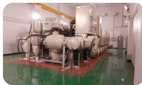
สถานีไฟฟ้าย่อยแบบใช้ฉนวนก๊าซ
