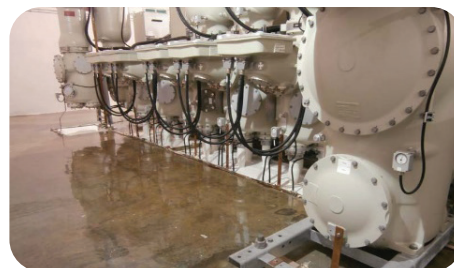
สถานีไฟฟ้าย่อยแบบใช้ฉนวนก๊าซ
