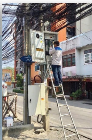
การติดตั้ง และวางระบบอุปกรณ์ MSAN
