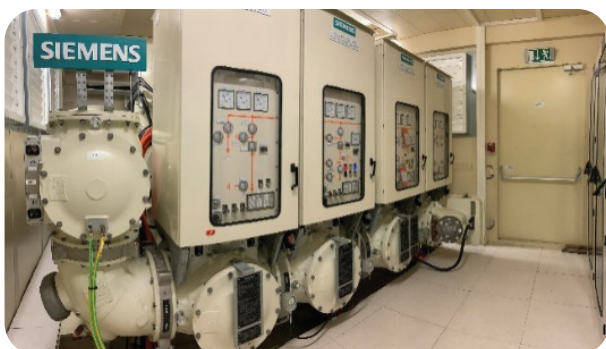
สถานีไฟฟ้าย่อยแบบคอนเทนเนอร์
