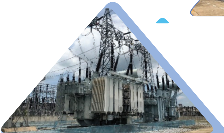
สถานีไฟฟ้าย่อยแบบใช้ฉนวนอากาศ
