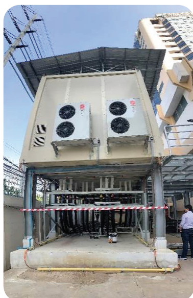
สถานีไฟฟ้าย่อยแบบคอนเทนเนอร์
