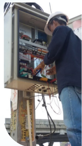
การติดตั้งและวางระบบอุปกรณ์ FRTU
