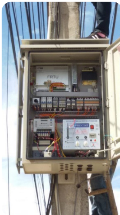
การติดตั้งและวางระบบ FRTU
