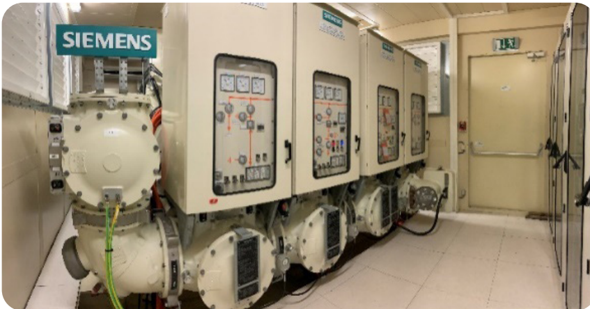
สถานีไฟฟ้าย่อยแบบคอนเทนเนอร์
