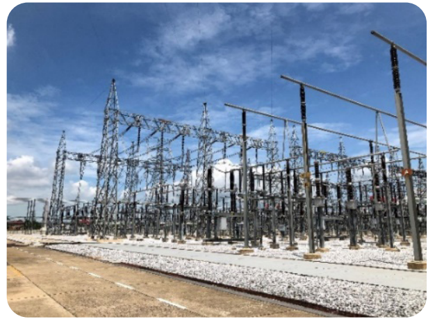
สถานีไฟฟ้าย่อยแบบใช้ฉนวนอากาศ
