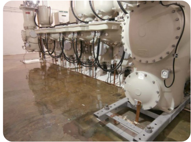
สถานีไฟฟ้าย่อยแบบใช้ฉนวนก๊าซ
