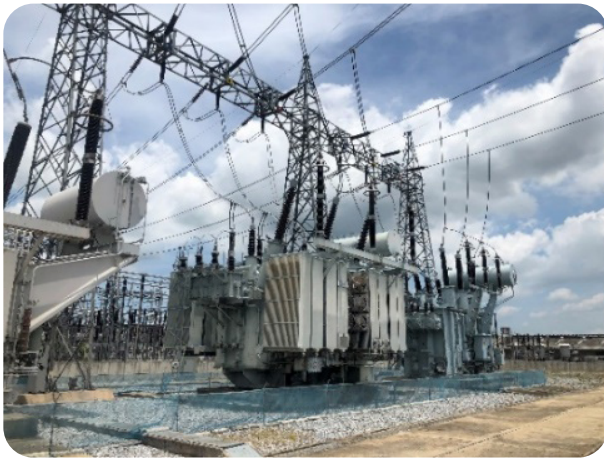
สถานีไฟฟ้าย่อยแบบใช้ฉนวนอากาศ
