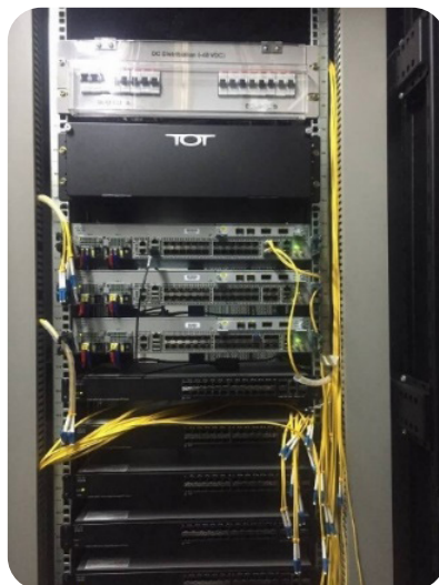
การติดตั้ง และวางระบบอุปกรณ์ MSAN
