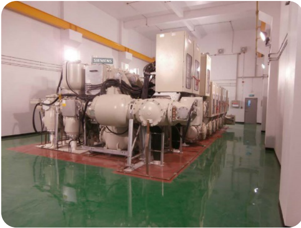
สถานีไฟฟ้าย่อยแบบใช้ฉนวนก๊าซ
